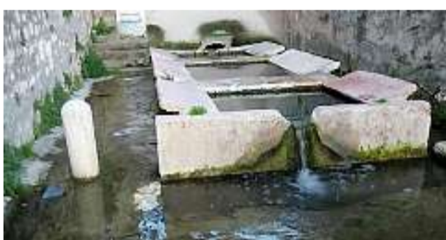
Per risolvere il problema servono nuove tubazioni
